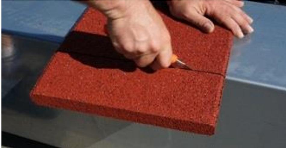
**Schneiden Sie die Platte bei Bedarf zu.**
