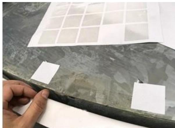
**Schließen Sie die Sprungrahmenöffnungen (nach dem Säubern der Oberfläche) mit den Etiketten (Pos. 12)**
