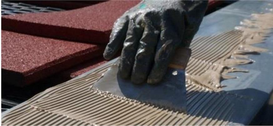
**Tragen Sie den Kleber gleichmäßig auf und kleben Sie die Fallschutzplatten fortlaufend auf.**
